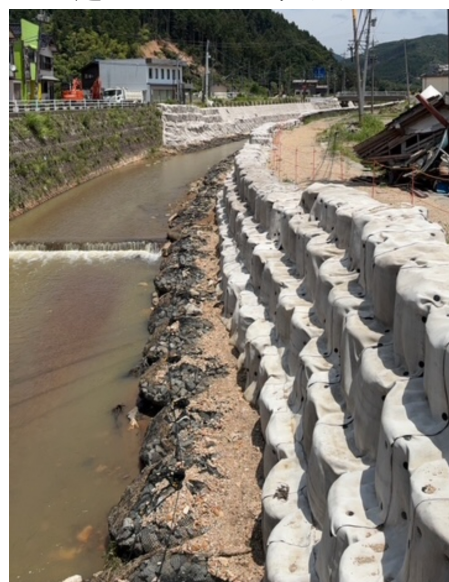
河川の応急護岸工事の状況（輪島市町野町）
